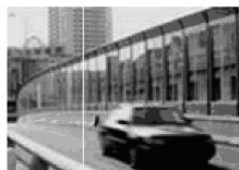
路边安装隔音幕墙
